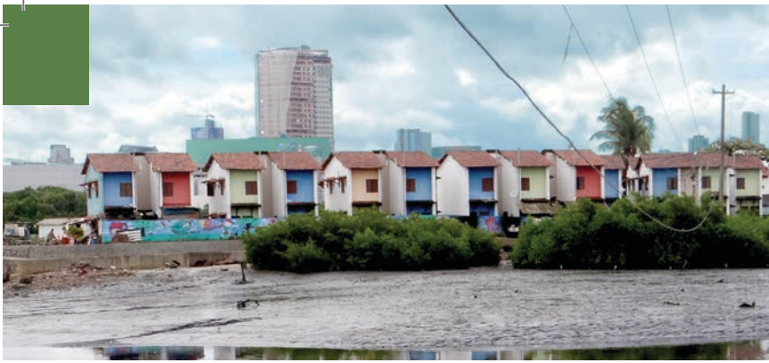
As novas casas da Ilha de Deus atenderam as demandas dos moradores; serão construídas, ainda, 300 unidades
